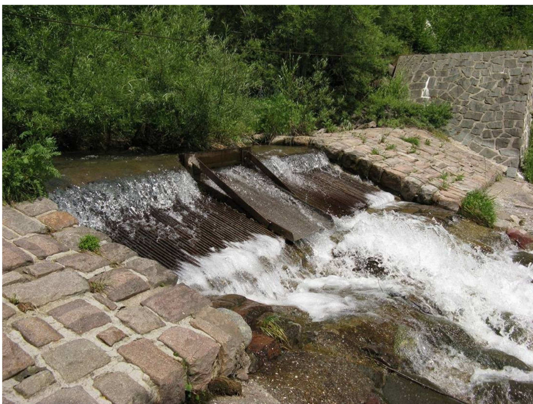
Fig. 38 - Opera di presa a scopo idroelettrico sul Torrente Fersina al servizio dell'impianto idroelettrico di S. Orsola.
