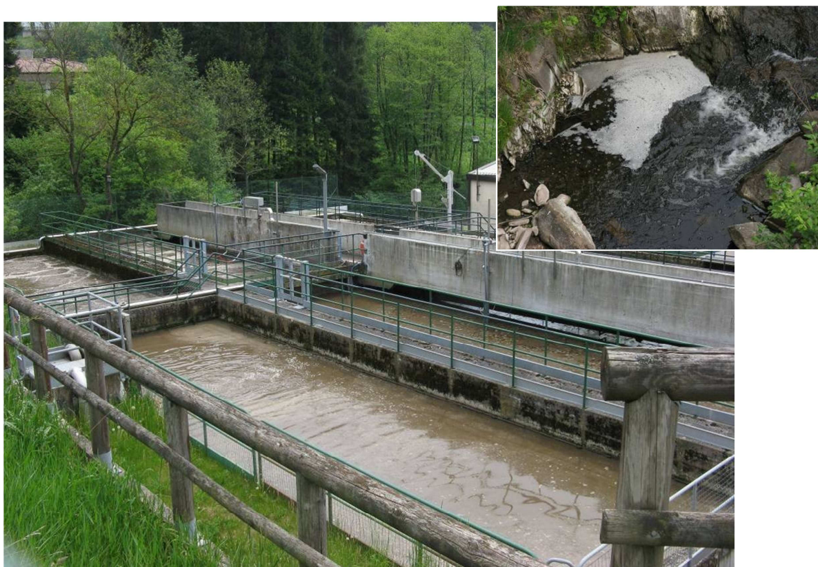
Fig. 33 - Depuratore biologico di Baselga di Pinè, in loc. Tressilla; lo stato di qualità ecologica del corpo idrico recettore (Rio Silla) ne dimostra l'insufficiente capacità di depurazione.
