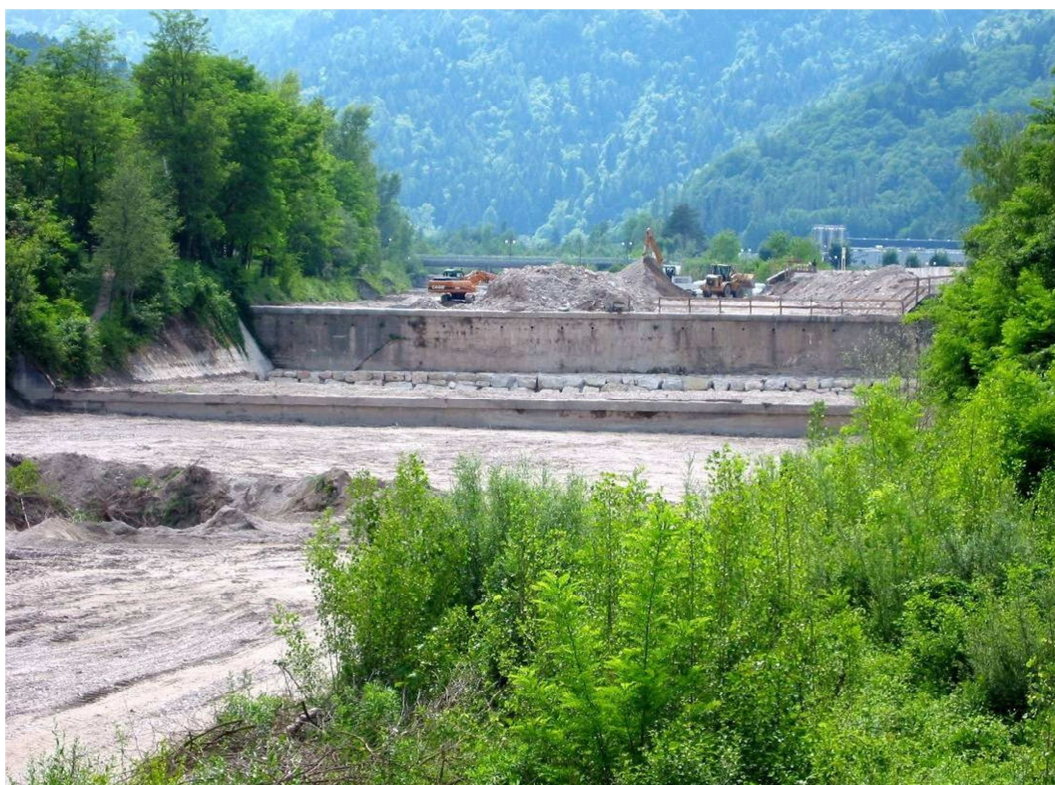
Fig. 37 - Imponente briglia di ritenuta sul basso corso del T. Centa.
