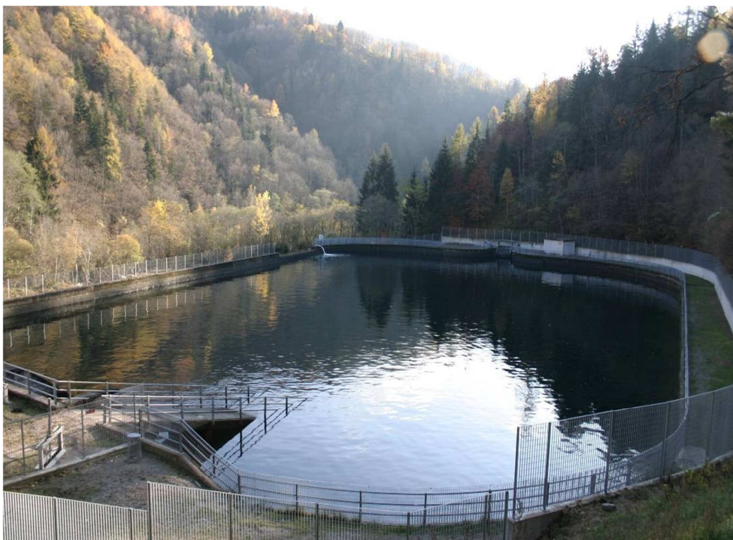
Fig. 21 - Bacino artificiale d'invaso a scopo idroelettrico con derivazione dal T. Fersina (Bacino Cima-dom, S. Orsola Terme, impianto idroelettrico STET di Canezza).
